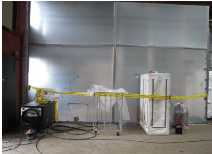
Containment met onderdruk-unit, onderdruk registratie-apparaat, materiaalsluis en luchtpomp voor het verrichten van luchtmetingen
