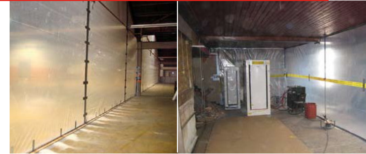
Folie-wand geplaatst ter afscherming (t.b.v. vormen van een containment)
