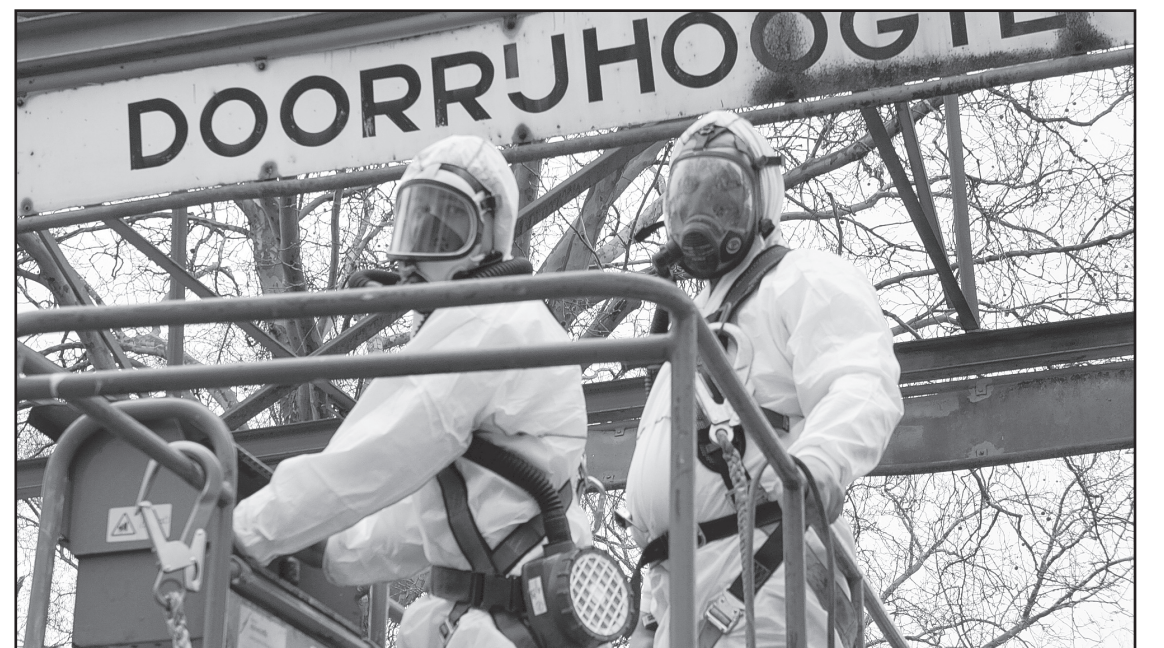
In Nederland moet personeel dat asbest verwijdert, volledig beschermd zijn. Dat is op straffe van boetes door de overheid, maar ook doordat bedrijven zoals Horyon dat werknemers verplicht.
