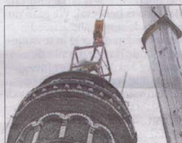
De werkbak met de asbestsaneerder verdwijnt in de schoorsteen.
